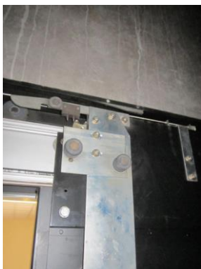
Serrure de porte palière du niveau principal
