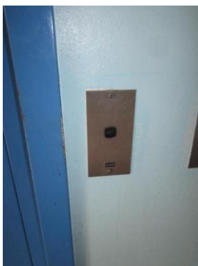
Commande palière du niveau principal
